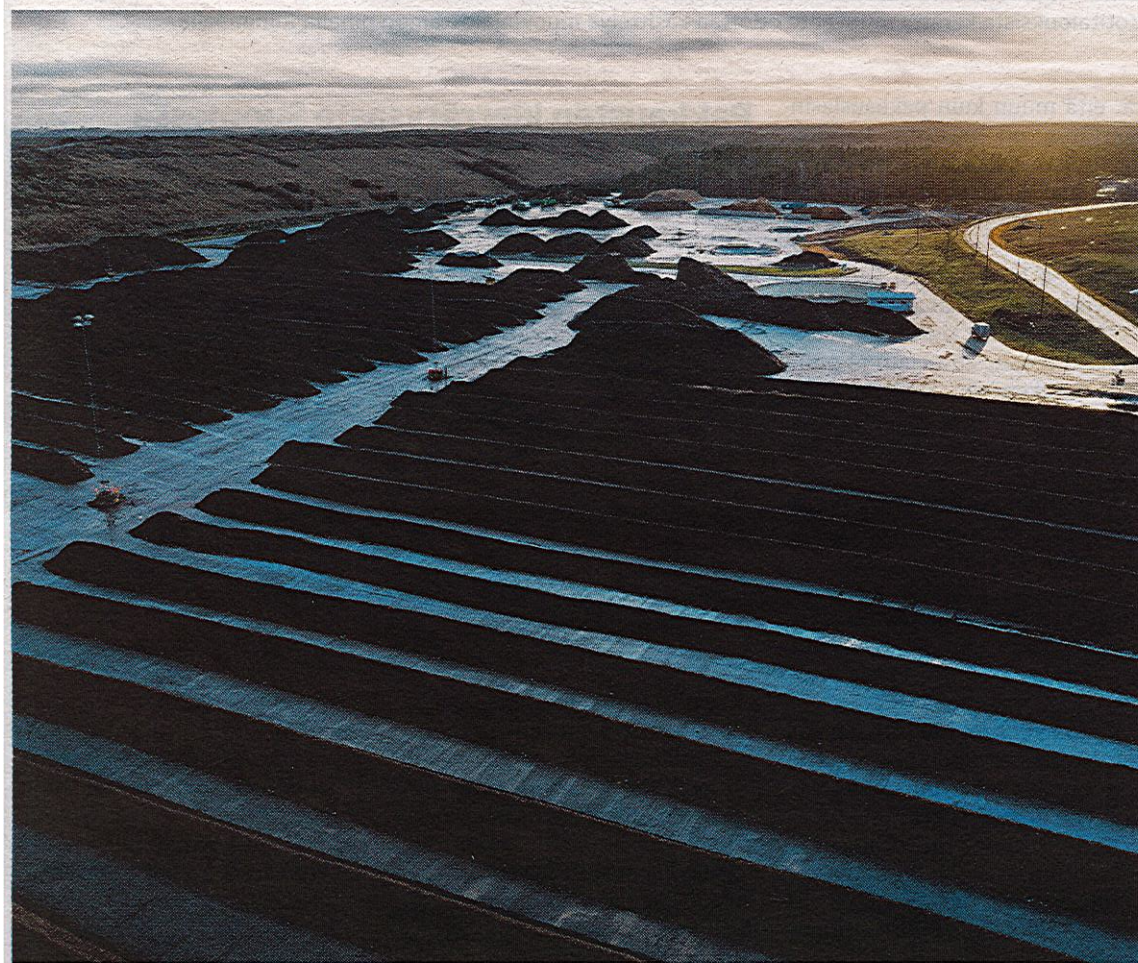
Komposti jälkikypsyys ulkoauimoissa Ämmässuon biojätteen käsittelylaitoksella Espoossa. Laitoksella tehdään biojätteestä multaa ja biokaasua.
