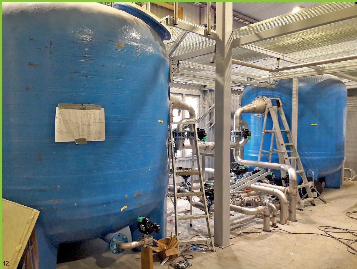
Jätekeskuksen uusi jätevedenpuhdistamo valmistui lokakuussa.
